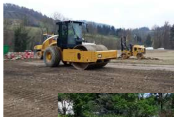
Pose de réseaux
