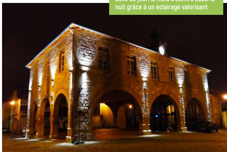
Le clocheton rénové est visible de loin
