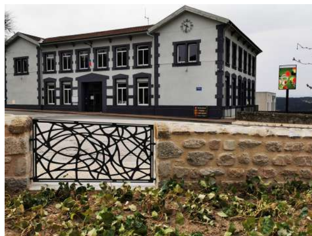
Le nouveau carrefour de la mairie : travaux achevés en 2022
