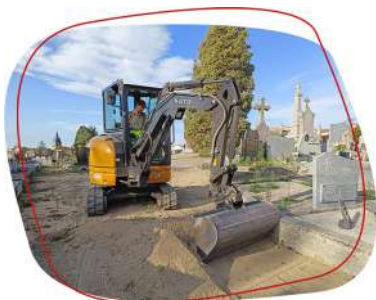
Travaux de préparation du sol avant l'engazonnement
