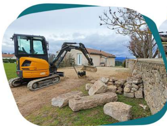
Les travaux entrepris par la commune au printemps
