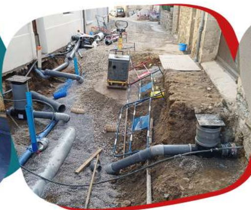
Les travaux concernent les réseaux d'eau potable, d'eaux pluviales et les réseaux d'assainissement des eaux usées.
