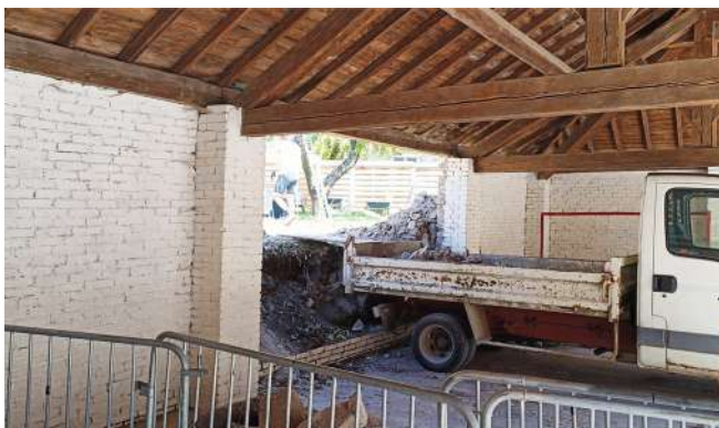
Destruction du mur du préau, puis reconstruction, été 2023
