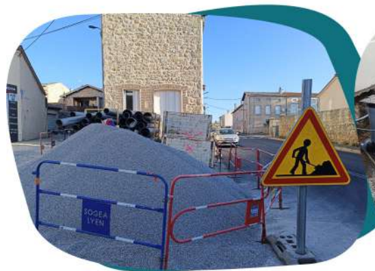
La rue du Canard longe la RD500, à hauteur du cimetière.
