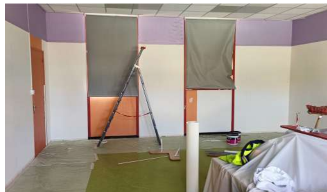
Rénovation de la salle des couchettes par les services techniques de la commune
