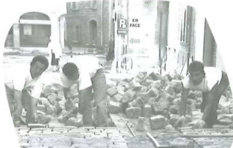
Travaux par les services techniques de la commune, bulletin municipal 1997
