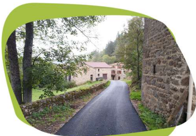
Nouvel enrobé au hameau de Guignonnet.
