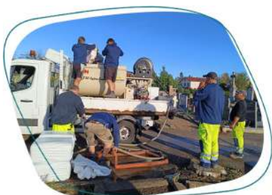
Préparation du mélange d'engazonnement
