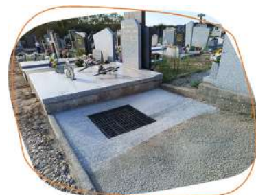
Pose de caniveaux par les services techniques de la commune
