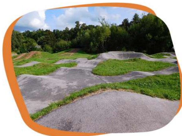
Une pump track est une piste en boucle, constituée de bosses et de virages relevés, qui peut être utilisée avec différents équipements sportifs, dont les VTT ou les BMX.
