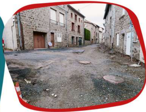
Rénovation des réseaux d'eau.
