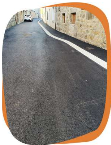
Nouvel enrobé pour la rue située le long de la RD 500.
