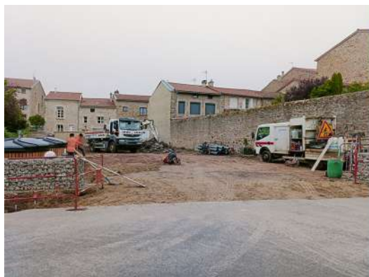
Les travaux étalés sur l'année ont permis la mise en service du parking fin octobre 2024.
