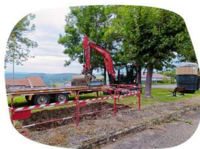
Travaux de préparation pour la mise en place d'un point d'apport volontaire, rue des Roses.
