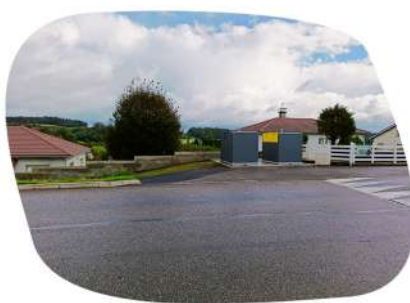
Installation de points d'apport volontaire hors sol, sur dalle, en bordure de RD 500.
