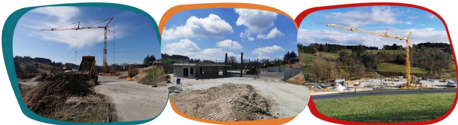
Les travaux de terrassement ont eu lieu en début d'année.
