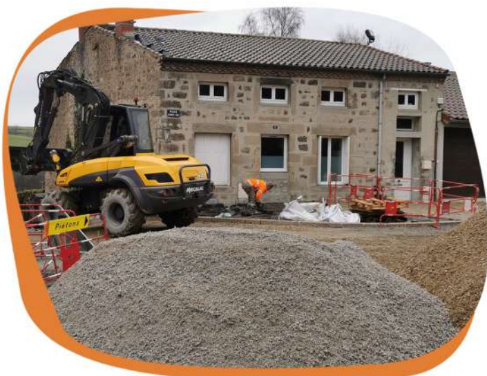
Travaux place Jeanne d'Arc.
