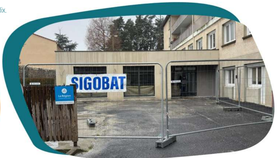
Le futur cabinet dentaire a été créé sous la maison médicale.
