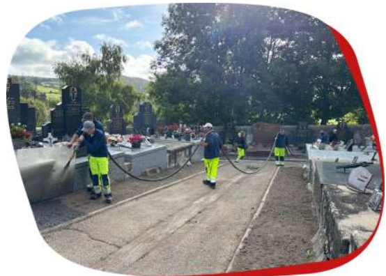
Les membres des services techniques ont projeté le substrat et les graines dans les allées du deuxième cimetière.
