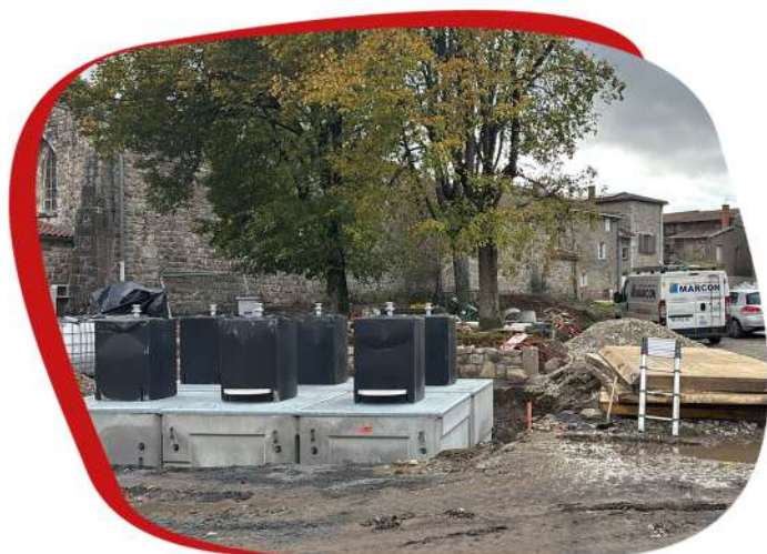
Installation des conteneurs enterrés, derrière l'église.
