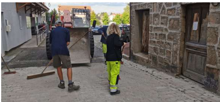
Sablage des pavés par les services techniques de la ville.
