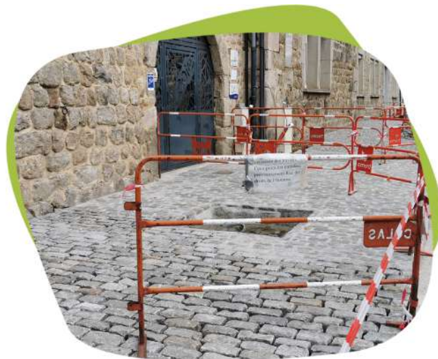
Pose de pavés boulevard des Jardins.
