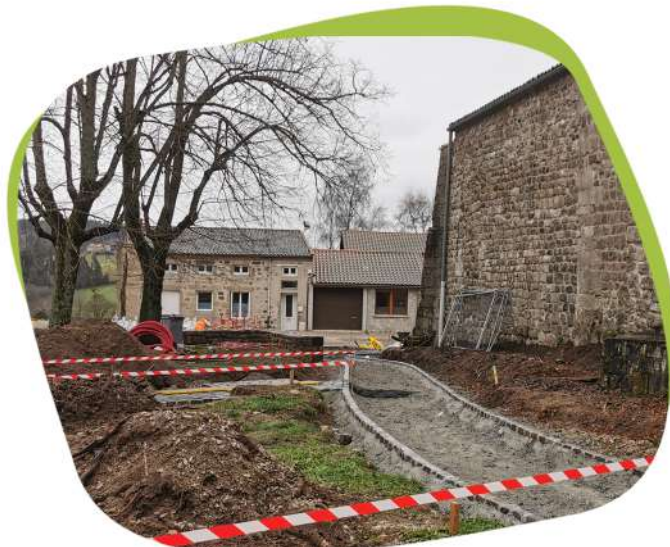
L'aménagement de cheminements piétons sécurise l'espace.
