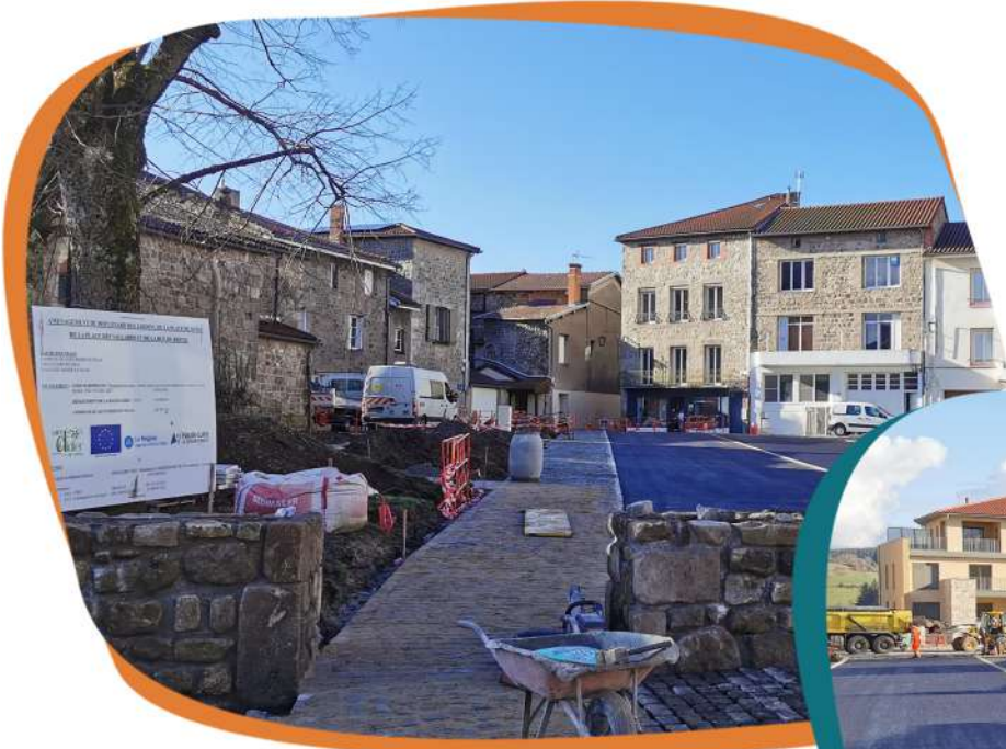
Création de murets pour délimiter les espaces.
