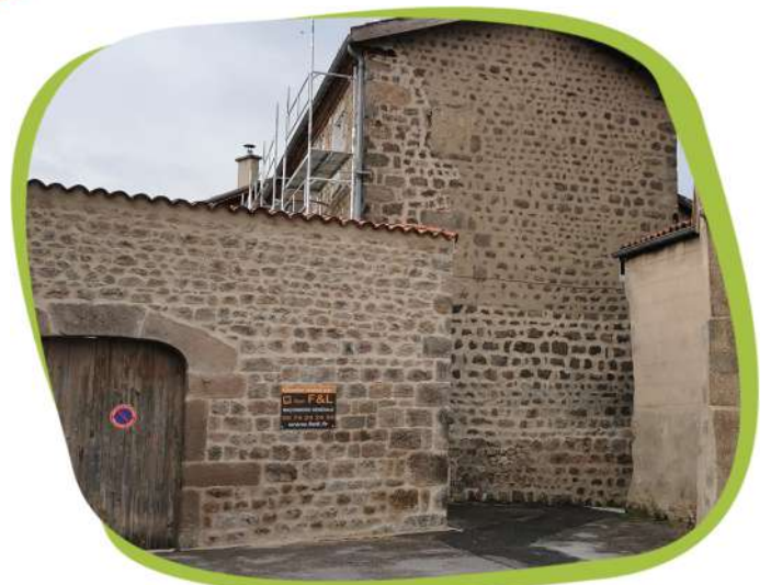
Travaux de restauration des façades de la cure, place des Dames.
